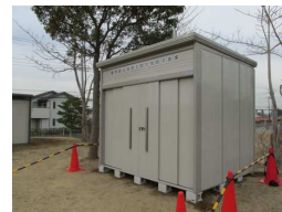
霜月防災倉庫
